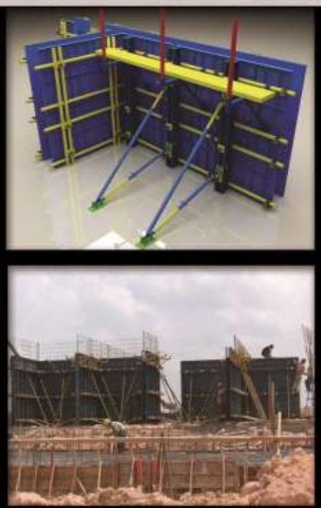
این سیستم همان طور که از اسم آن پیداست به دلیل ضریب مدولاسیون استانداردی که برای آن در نظر گرفته شده، انعطاف پذیر بوده و به راحتی در تمام جهات قالب گسترش بوده و استفاده های متنوعی در اجرای کلیه سازه های بتنی از قبیل شالوده، ستون، دیوار، تیر، دال و... دارد و مشکل از قالب های مدولار، کنج های مدولار، پشت بندها (لوله، سولجر...)، اتصالات (گوشه، انواع گیره، انواع بولت، انواع واشر و مهره) و شمع های حمایتی (جک های دو بازویی، جک های تلسکوپی و ...) می باشد.
