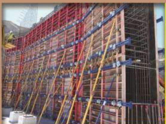
این جک ها دارای یک لوله بیرونی به قطر 6CM می باشد که در انتهای آن پیچ تنظیم و مهره جوش داده شده است. لوله درونی این جک ها به قطر 5CM می باشد که سوراخهایی به منظور تنظیم ارتفاع روی آن تعیین شده است. این جک ها در دو انتهای خود دارای دو گفتشک جهت اتصال به زمین و سولجر می باشند. باربری این جک ها به مراتب بیشتر از جک شاقول کننده می باشد.
