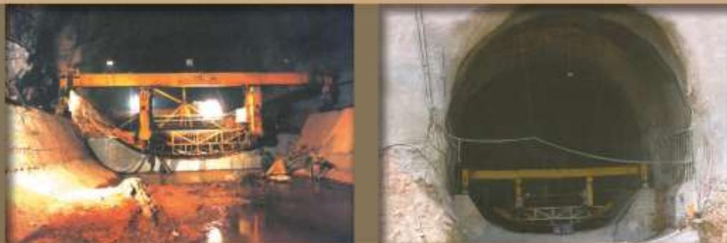
در مرحله بعدی قالب تاج (سقف) و دیواره (که در سه قسمت ساخته می شود) با توجه به مقطع مورد نیاز ساخته و پس از فرار گرفتن در داخل تونل و مطابقت با بتن ریخته شده کف عملیات بتن ریزی صورت گیرد. قابل ذکر است در برخی تونل ها با توجه به مقطع خاص می باشد
