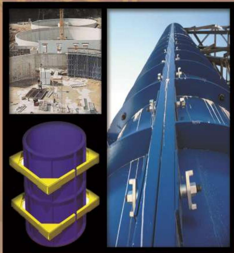
برای اجرای دیواره‌ای که قطر آن بین ۲m تا ۷/۵m باشد از قالب مدولار کمانی استفاده می‌شود. این قالب‌ها قادر تسمه‌های افقی می‌باشند و در نتیجه با توجه به شعاع لوله نورد شده‌ای که به عنوان پشت بند افقی به آنها متصل می‌گردد، قرم می‌گیرند.
