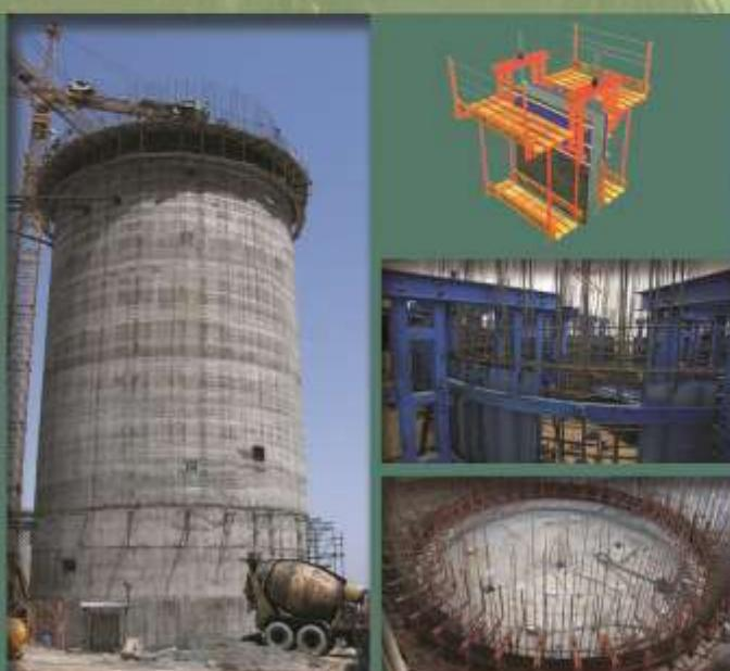
این سیستم بیشتر در سازه های مرتفعی به کار می رود که دیوار نقش اصلی را در آن ایفا می کند مانند سیلوهای دودکش ها و... سیستم اجرای قالب های لغزنده بسیار پیچیده است و نیاز به پشتیبانی بسیار زیادی در زمان اجرا دارد، اجزای این سیستم تشکیل شده از قالب های خاص، شاسی مخصوص، جک های میمونی بالا رونده و... که با توجه به مشخصات فنی سازه مورد نظر طراحی می شود.
